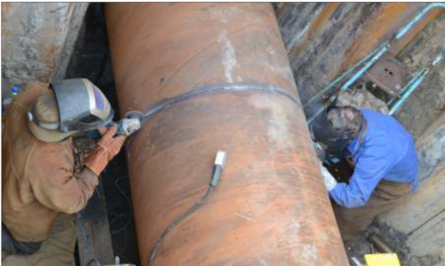
Schweißarbeiten am neuen Stahlrohr unter der Theodor-Körner-Straße (Fotos: Kirsten Schielke)
