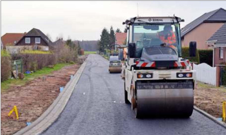
Asphaltwalzen in der Straße „Boddenblick“
