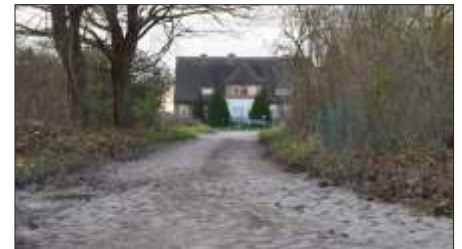
Der Ahornweg in Leist 1 muss saniert werden
