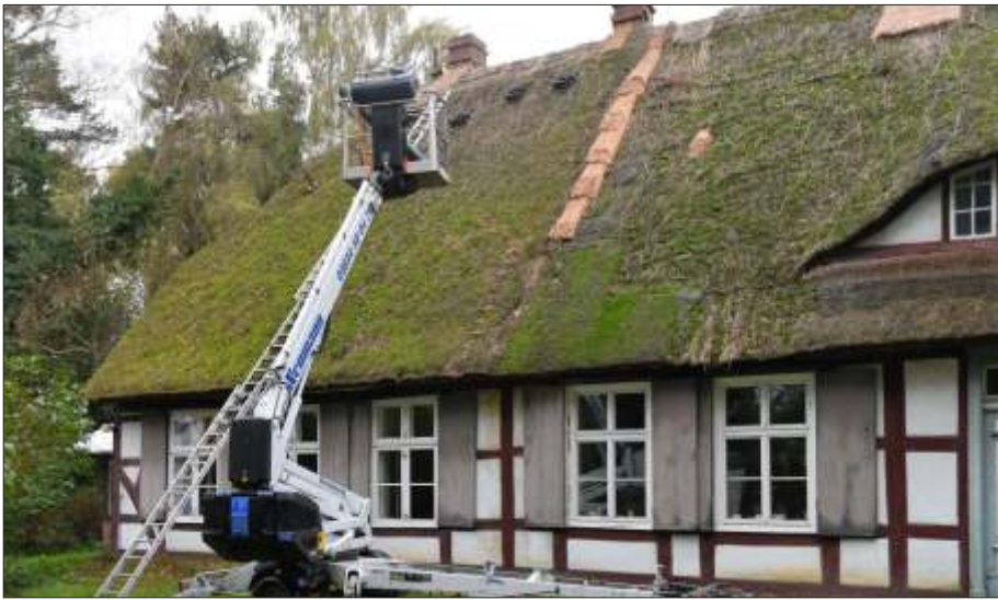
Mit einem Hubsteiger haben die Dachdecker die schweren Bitumenbahnen auf den First gebracht.
